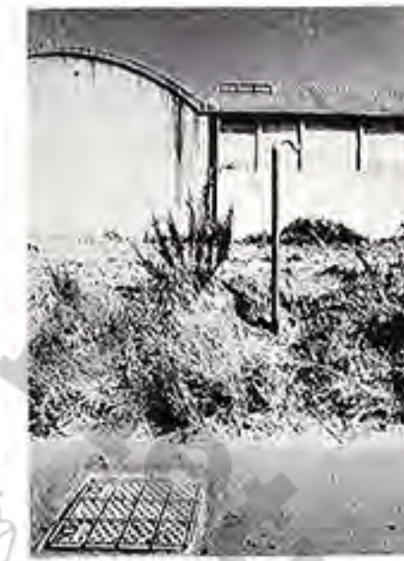
1974 - METANODOTTO 4 (ingresso in città)
