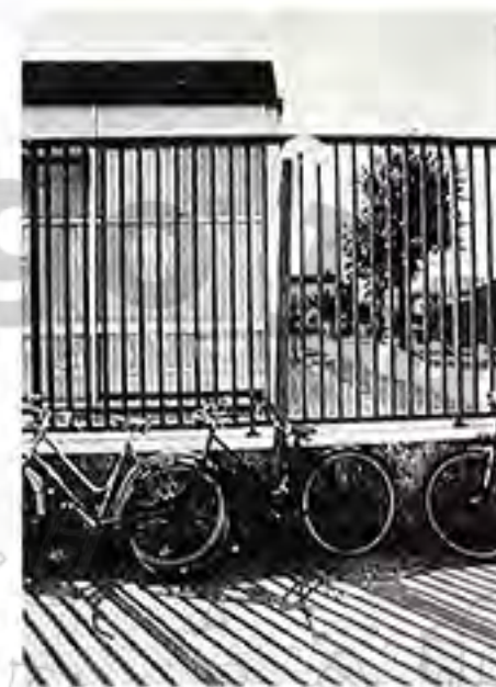
1974 - METANODOTTO 3 (ingresso in città)
